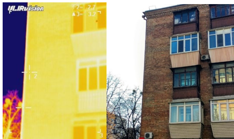
Рисунок 2 – Тепловізійна зйомка фасаду житлової будівлі
