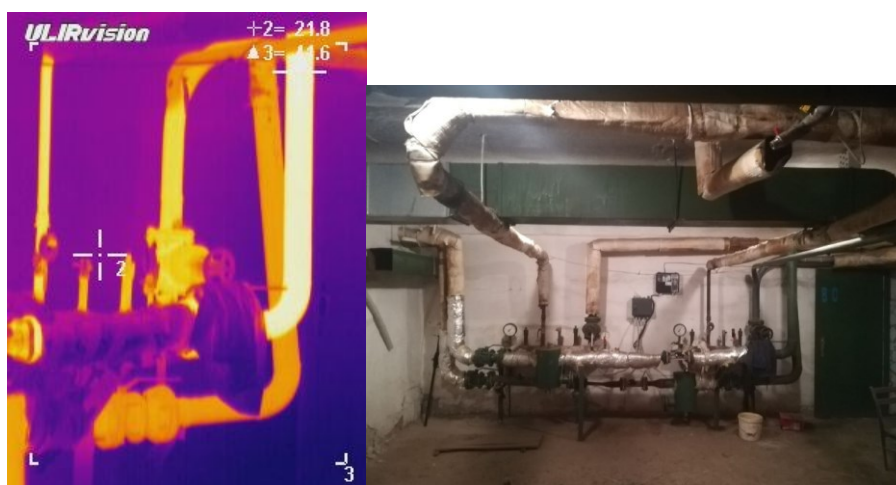
Рисунок 2 – Тепловізійна зйомка теплового пункту будинку
